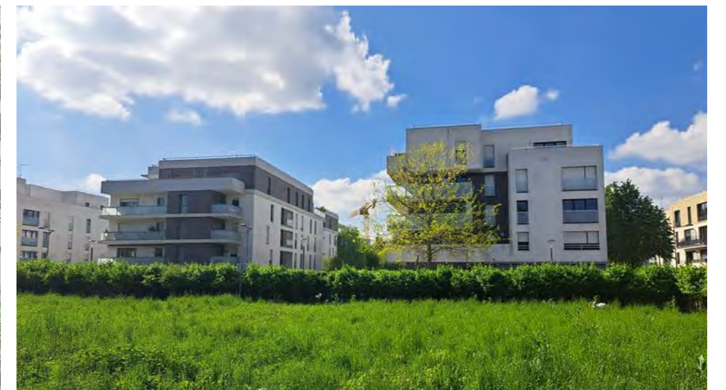
Immeubles collectifs le long de la rue du Clos Saint Michel
