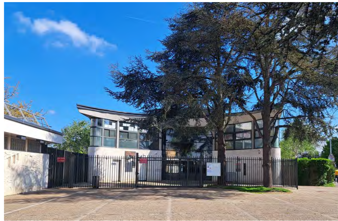
Collège Jean Moulin, à Chevilly Larue, à proximité immédiate du site
