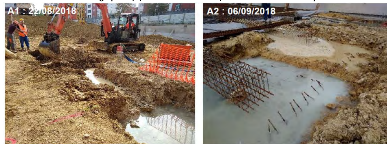
Photographies (A) du chantier situé au 3, rue de Provence à Chevilly-Larue
