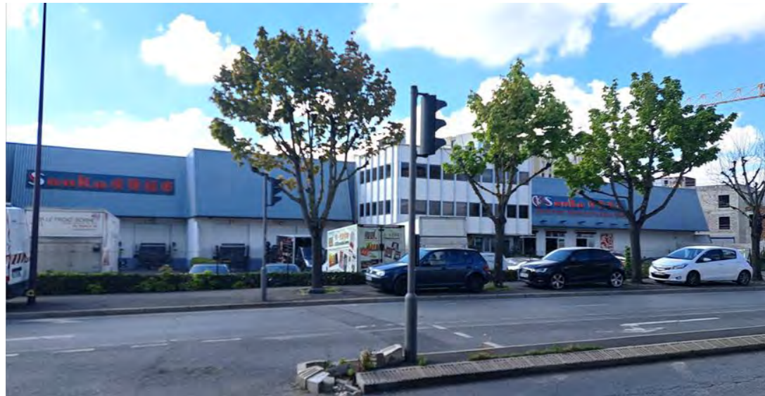
La zone d'activités du plateau au nord de la rue de Bicêtre
