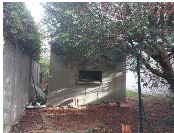
Infrastructures au droit de la parcelle
