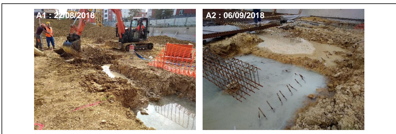
Figure 25 – Photographies (A) du chantier situé au 3, rue de Provence à CHEVILLY-LARUE
